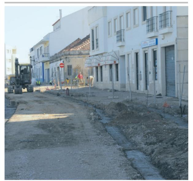
Na zona ribeirinha de Alcochete as obras de requalificação do miradouro Amália Rodrigues continuam em curso. Depois dos trabalhos de remoção, movimentos de terra, construção parcial de redes de drenagem e iluminação, a empreitada prossegue com a execução das bases dos pavimentos, estando ainda por concretizar a construção de muros, guias e lancis, trabalhos de pavimentação, criação de zonas verdes, instalação de rede de rega e mobiliário urbano. ■
