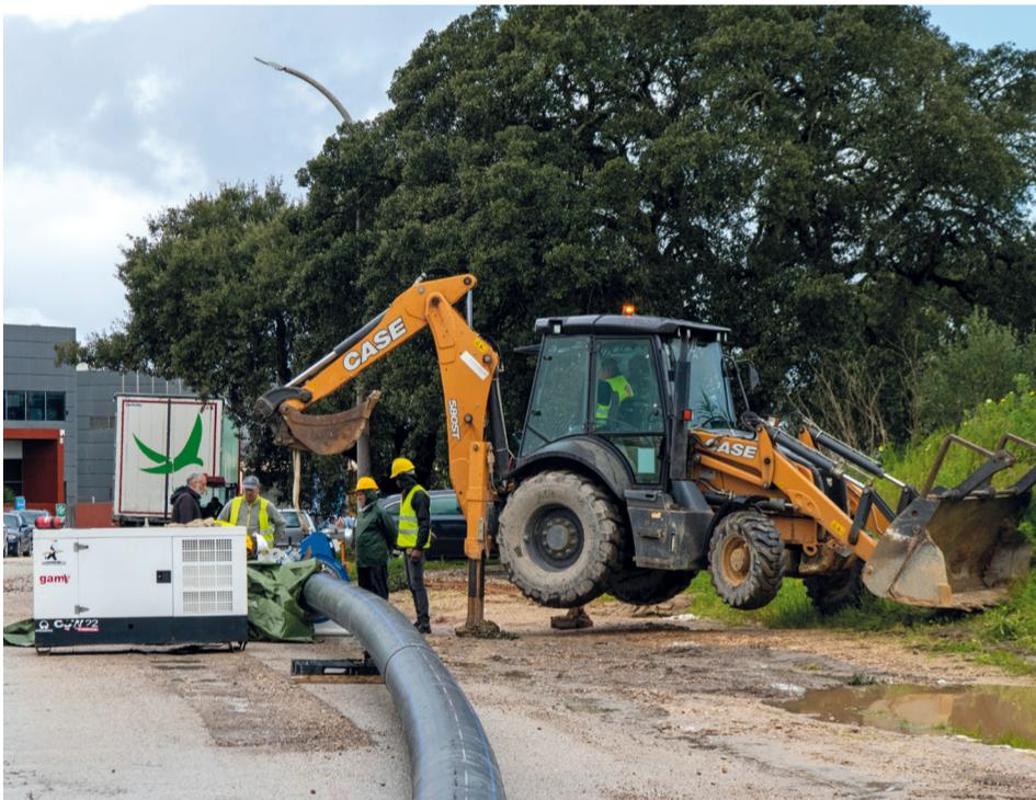
Continuam a avançar as obras de renovação da rede de condutas de adução e de distribuição local de água em Alcochete, um investimento superior a 1 milhão e 100 mil euros e que tem como principal objetivo a instalação de uma segunda conduta, complementar à existente, que alimenta a rede de água das freguesias de Alcochete e São Francisco.
