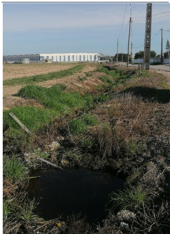
Fotografia 8 – Vista da vala que intercepta o percurso da antiga linha de água junto à estrada que liga a Rua do Aceiro à EM502
