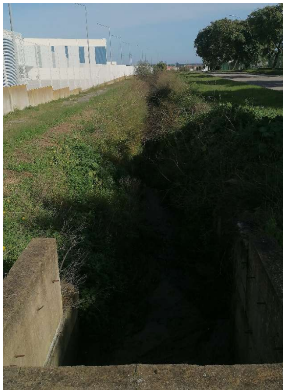
Fotografia 2 – Continuidade da vala da foto anterior, ao longo da Rua Quinta do Pereiro, após PH sob a Rua do Aceiro.
