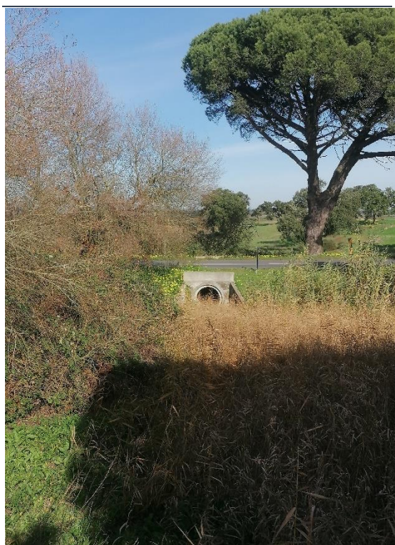
Fotografia 5 – Vista da PH de jusante sob a EN118
