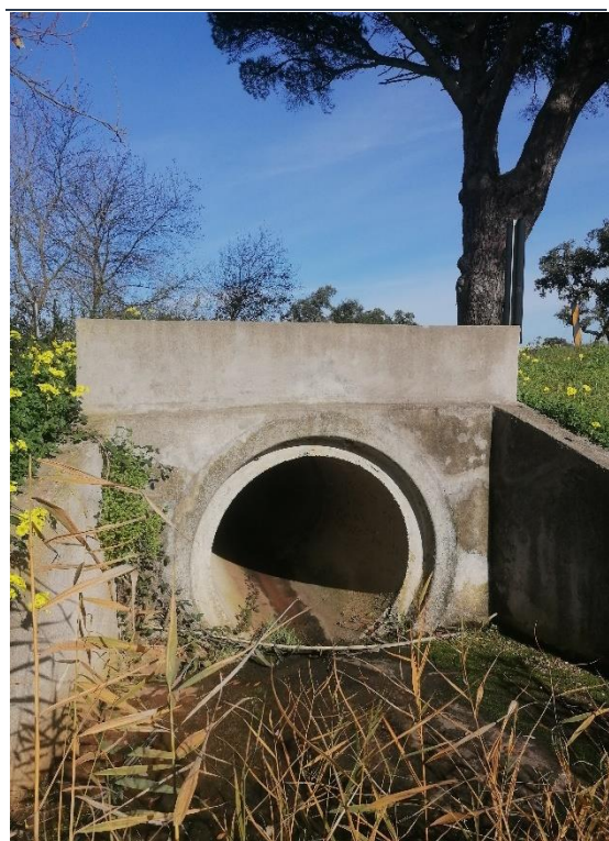
Fotografia 6 – Aspecto da PH de jusante sob a EN118, Ø1000
