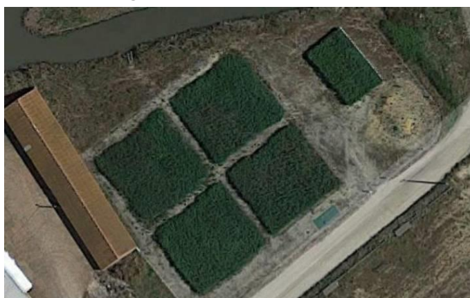
Fotografia 32: ETAR de Barroca d'Alva
