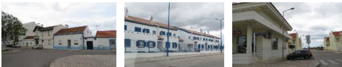
Fotografia 25: Edifícios com 1 ou 2 pisos dominantes
