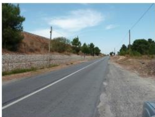
Fotografia 35: Taludes do IP7/A12
